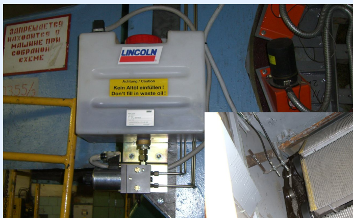
Система смазки цепей эскалатора
