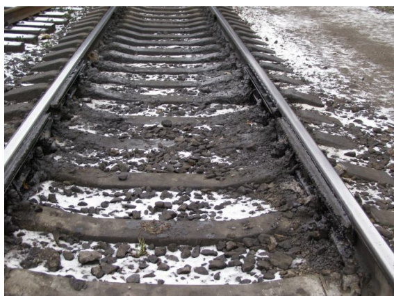
Рельсосмазыватель после годовой эксплуатации
