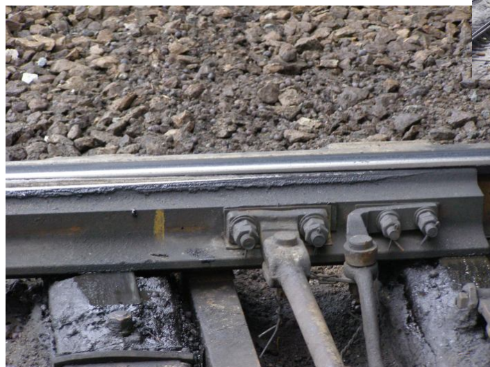
Разнос смазки на стрелочных переводах
