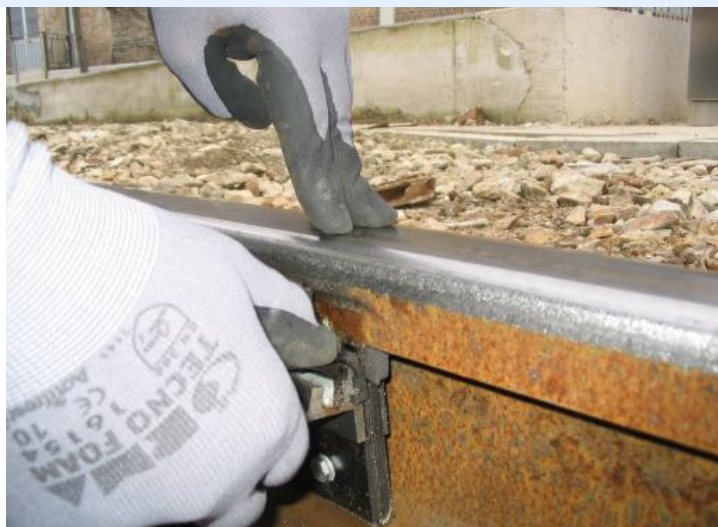
Монтаж крепления шины
