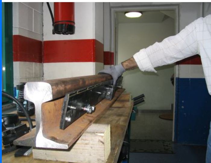
Вид смонтированной шины с второстепенным распределителем
