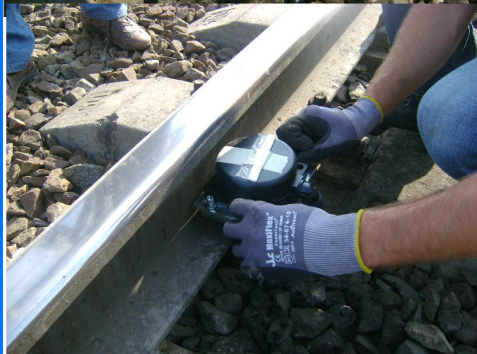
Установка сенсорного датчика
