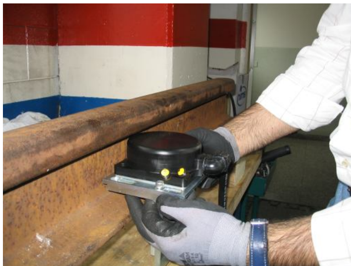
Монтаж сенсорного датчика
