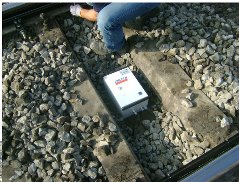
Установка защитного шкафа с главным распределителем
