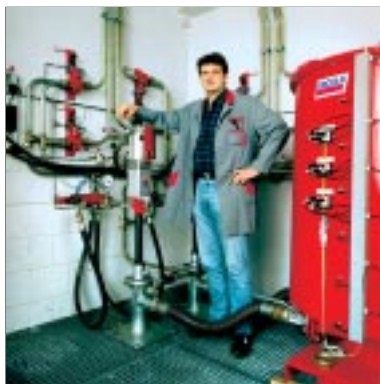
Обеспечение смазочным материалом с помощью контейнерного насоса
